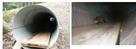
横断管渠の設置(ほ乳類等対象)
