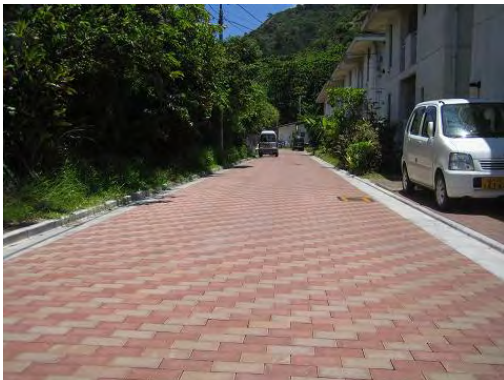
▲インターロッキングブロック舗装された道路
