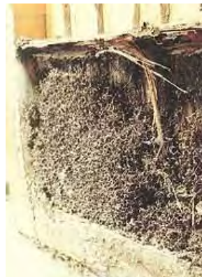
▲シロアリの被害にあった家屋の状況
