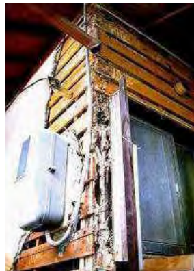
▲シロアリの被害にあった家屋の状況
