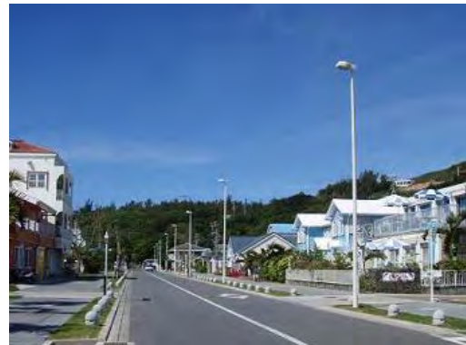
▲無電柱化された道路
