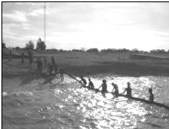
係留施設がないため人力でパイプラインを接続
