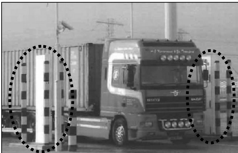
【放射性物質検知施設(蘭・ロッテルダム港の例)】
