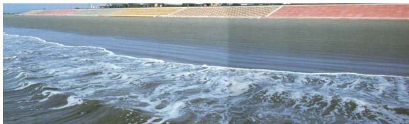
必要以上に存在感が強調され、 周辺から浮き上がる緩傾斜護岸の例
