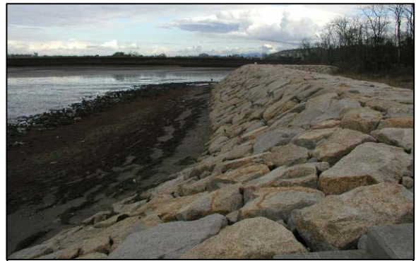
未整備区間に整備された捨石堤
