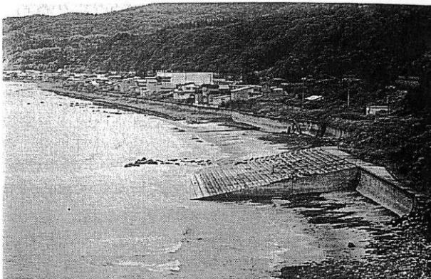
緩傾斜堤（整備前）
