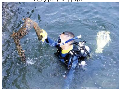
海底状況の調査
