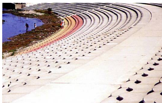
従来あった浜をつぶして階段護岸を造りすぎた例
