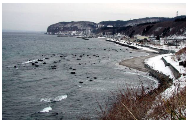
消波堤（再整備後）
