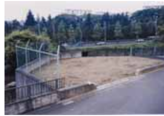
埋め立て後の状況
