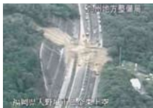
福岡県大野城市乙金(九州縦貫自動車道)被災状況
