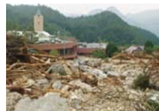
山口県防府市(特別養護老人ホーム)被災状況
