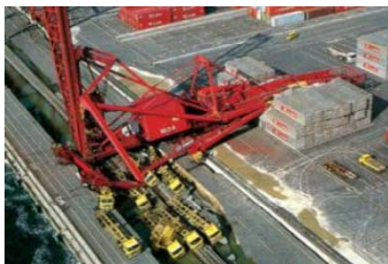
図 倒壊したコンテナクレーン
