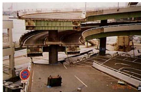
図 地震により崩落した橋梁
