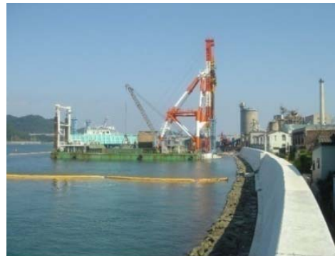
改良 (嵩上げ・耐震強化) 後
