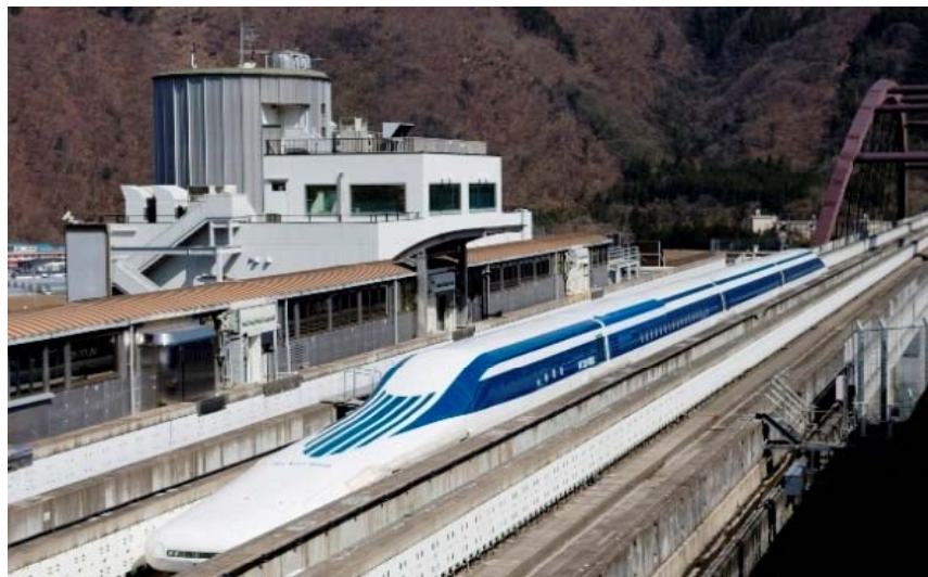
山梨実験センター及び走行試験中の超電導リニア車両
