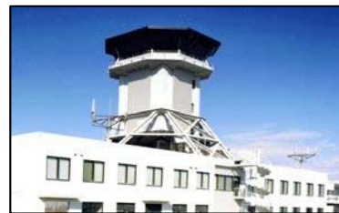
管制塔等の倒壊防止
