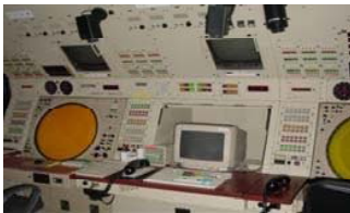
【老朽化した管制卓の更新】
