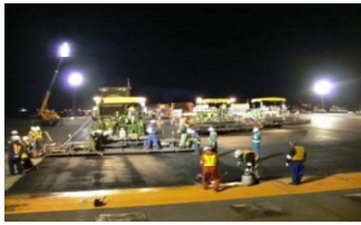
【滑走路舗装の改良】
