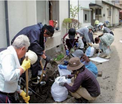
上／同じく陸前高田市。田の瓦礫撤去作業には、重機が使えないため、多くの人手を必要とする。下／岩手県釜石市で、側溝に溜まった汚泥の除去作業。
