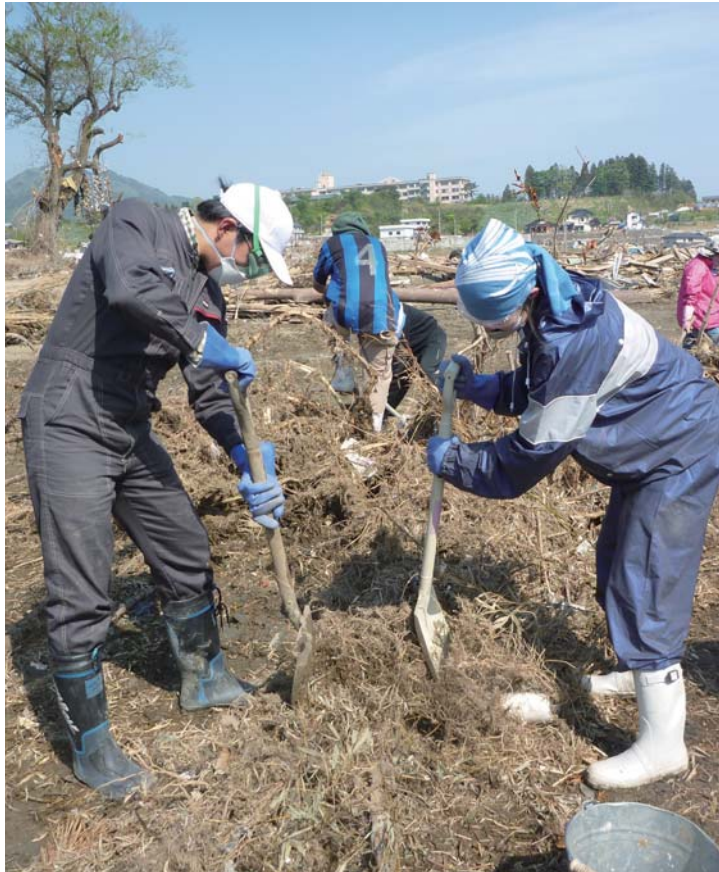
岩手県陸前高田市にて。住民からの「来年の田植えに備えたい」との依頼に応え、田を覆い尽くす瓦礫の撤去作業。
