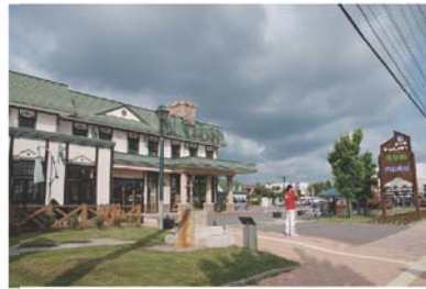
道の駅ひがしかわ「道草館」。
