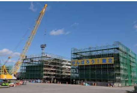
宮古港では、防波堤を修復するための「ケーソン」の製作が進んでいる。
