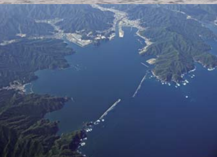
上/釜石の湾口防波堤(北堤)。来襲した津波は凄まじく、高さは10mを超え、防波堤をも破壊した。 左/釜石の湾口防波堤は北堤と南堤から成り、開口部は大型船も通過できる300m。防波堤は、1辺が30m四方、重さ16000tにも及ぶ"ケーソン"を並べて構成される。
