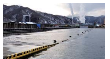
地盤沈下した釜石港では、潮汐（ちようせき）の影響により、岸壁が浸水している。
