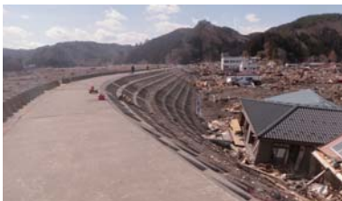
「万里の長城」とも呼ばれる宮古市田老（たろう）地区の防潮堤。津波で地区の約8割が全半壊となった被害を考慮し、県では堤防高10mを14.7mにする計画である。
