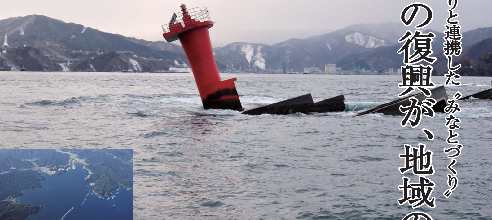
上/釜石の湾口防波堤(北堤)。来襲した津波は凄まじく、高さは10mを超え、防波堤をも破壊した。 左/釜石の湾口防波堤は北堤と南堤から成り、開口部は大型船も通過できる300m。防波堤は、1辺が30m四方、重さ16000tにも及ぶ"ケーソン"を並べて構成される。
