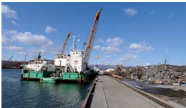
宮古港の藤原埠頭は約50cm沈下。現在は岸壁の嵩上げも含め、本格復旧を進めている。
