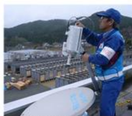
津波監視カメラの設置
