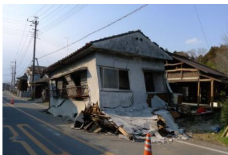
■ 図 7.5.2 木造建築物の被害状況
