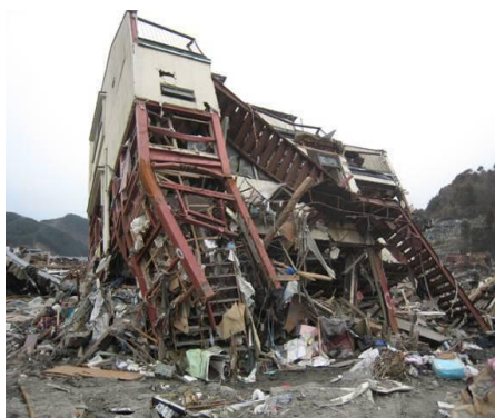
■ 図 7.5.1 建築物の津波被害状況
