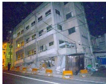
■ 図 7.5.3 鉄筋コンクリート造建築物の被害状況
