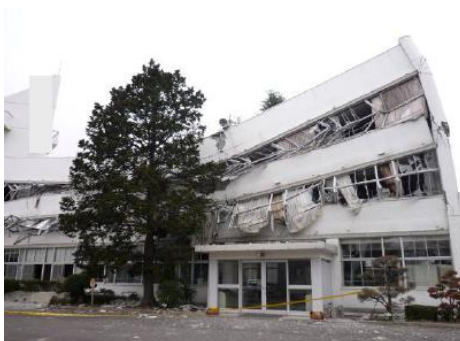
■ 図 7.5.3 鉄筋コンクリート造建築物の被害状況
