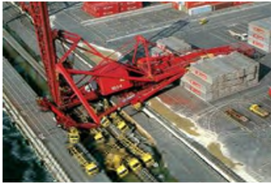
倒壊したコンテナクレーン
