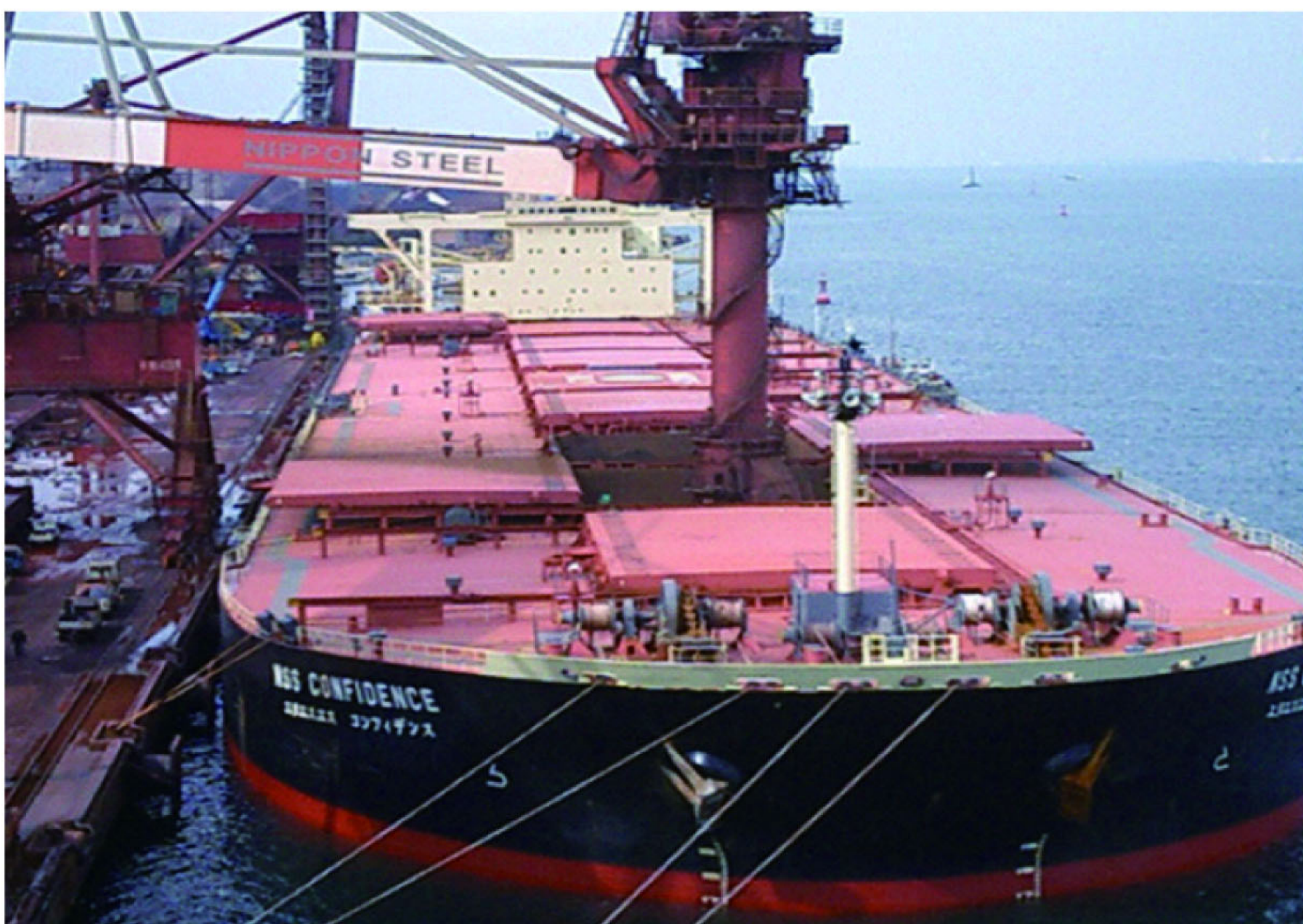
木更津港に寄港したバルク輸送船から、原料荷揚げ作業中。
