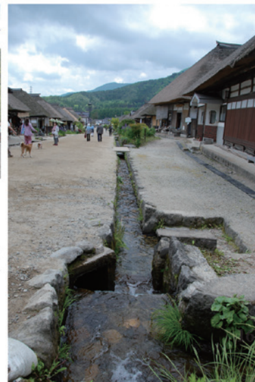
割石積の側溝。街道の両側には山からの清らかな自然水が引かれ、心地よい音をたてて流れている。
