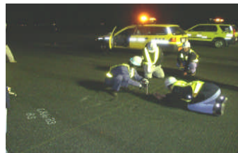
(予防保全的維持管理:点検実施状況)
