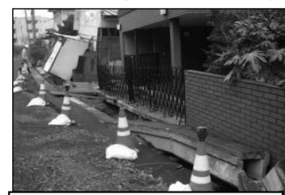
地震による地割れの例 （宮城県）
