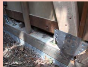
土台・柱・筋かいなどの接合部分には金物を使ってより堅固に。
