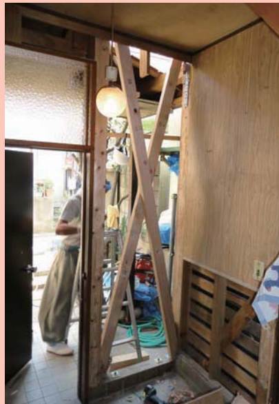
土台・柱・筋かいなどの接合部分には金物を使ってより堅固に。
