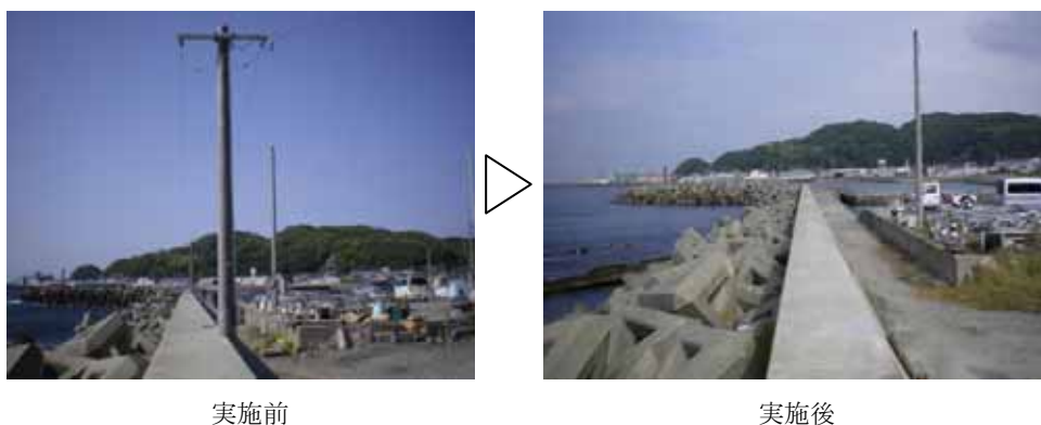
図表3-1-5 灯台の配電線撤去状況（千葉県富津市）
