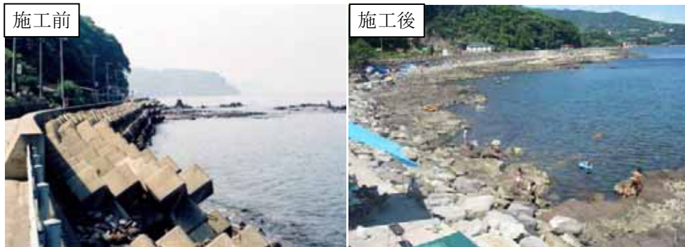
図表 3-4-1 消波ブロックを除去し、自然石を配置することで荒天時の高潮対策を図った海岸の例
