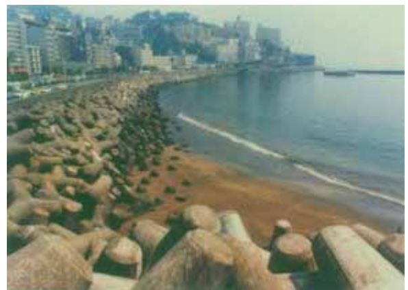
▲ 海岸を埋め尽くしていた消波ブロック (静岡県熱海市)
