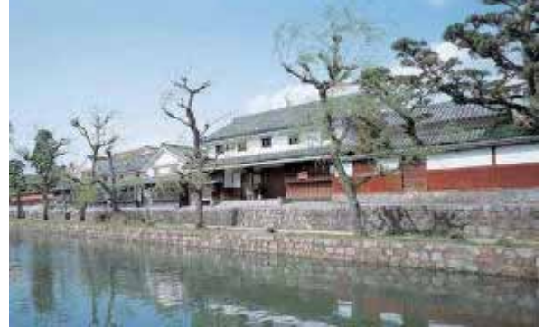
▲ 美観地区等や独自の景観条例により良好な景観を形成（岡山県倉敷市）
