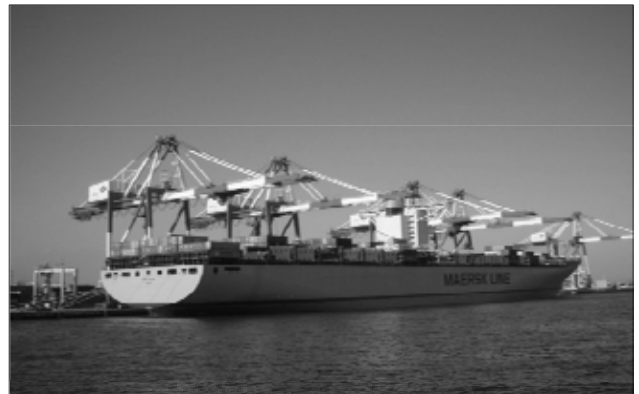
【横浜港 南本牧コンテナターミナル(MC-2)】
