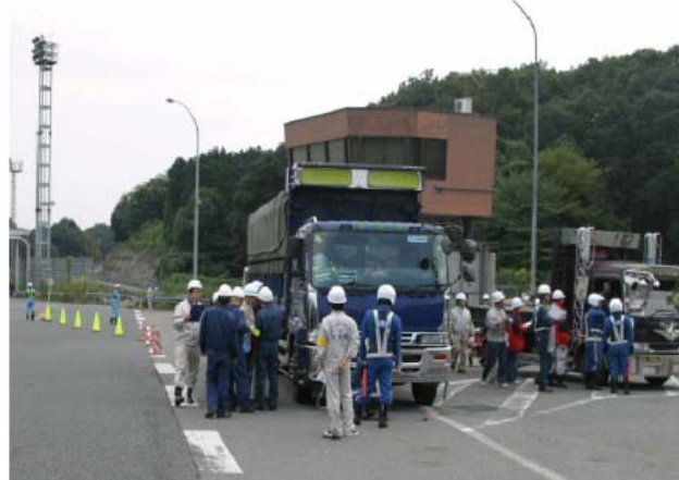
図 3-30 工事現場のパトロール
