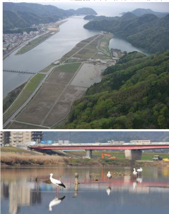
図 3-18 河川における湿地整備事例（円山川（兵庫県豊岡市））
