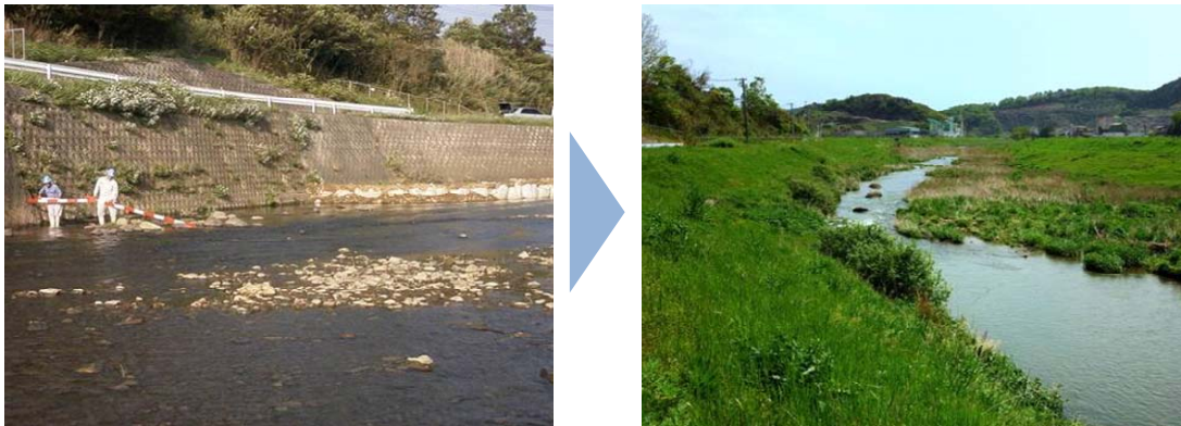
図 3-11 生物の生息・生育環境等の保全・再生（牛津川（多久市））
