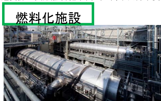
図 3-29 下水道資源の固形燃料化事例（広島市西部水資源再生センター）
