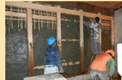
那須町の職人が参加した修理工事
