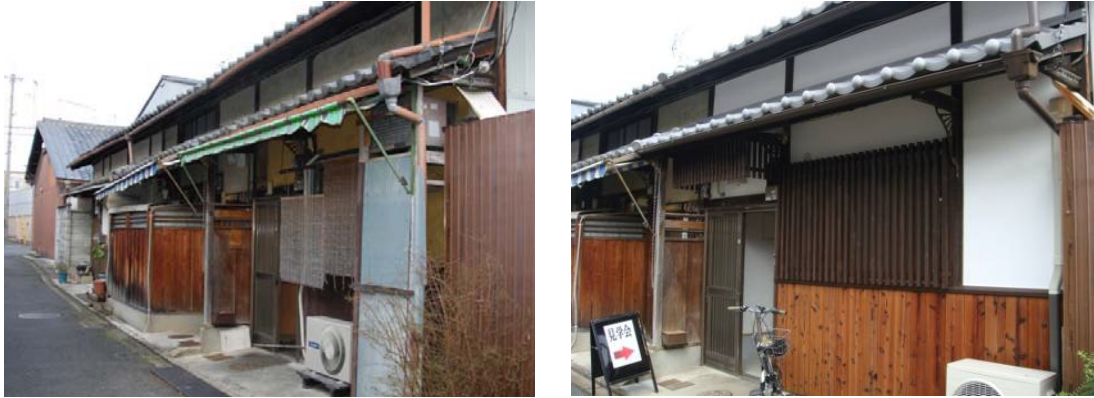
町家の改修前（左）と改修後（右）
