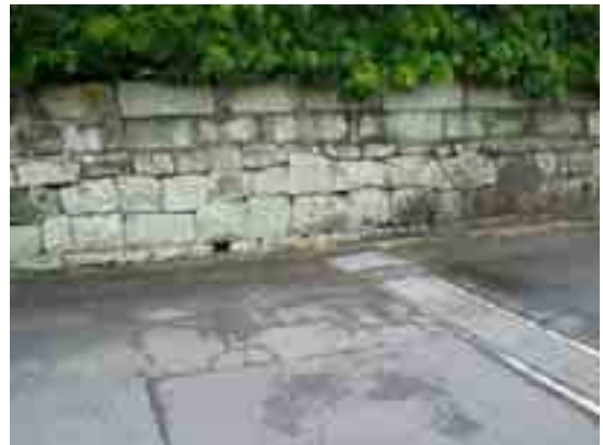
写真4-6 割石乱整層積み
