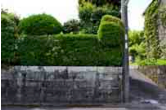
写真 4-3 切石整層積み
