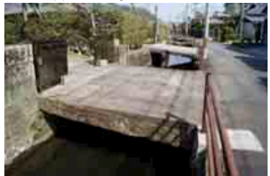
写真4-13 コンクリートで舗装された石橋
