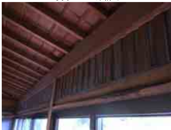
写真 4-30 縁上部の無双窓
