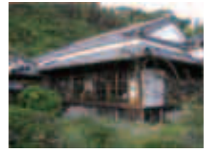
○入母屋の主屋に下屋庇が廻る形態
