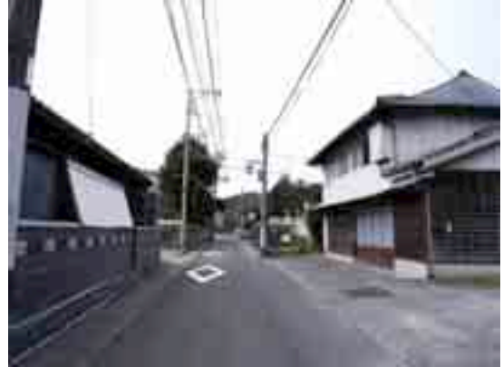
写真4-11 益山用水の暗渠化部分
