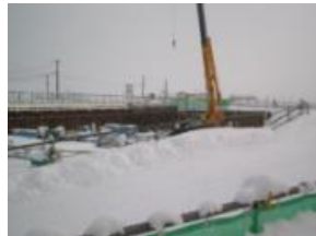
函館新駅建設地
