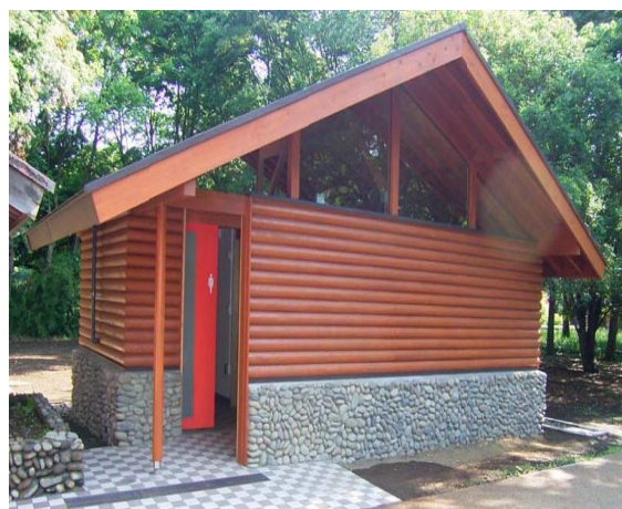
国営昭和記念公園 トイレ (東京都立川市、1階建て、31 m 2 )
