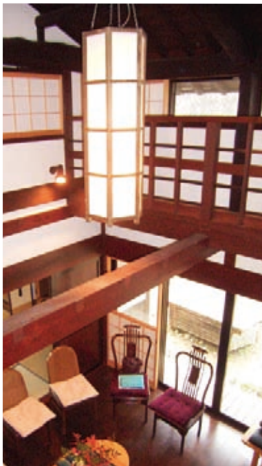
吹抜けと1階、2階に大きな窓を設置。外部風を取り込み、住宅内での空気の動きをうながす
