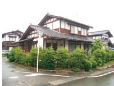
勾配屋根・瓦屋根（富山）
