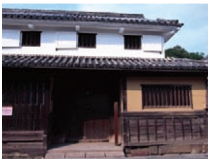
漆喰壁、瓦屋根の伝統的な住宅。落ち着きを感じさせる
