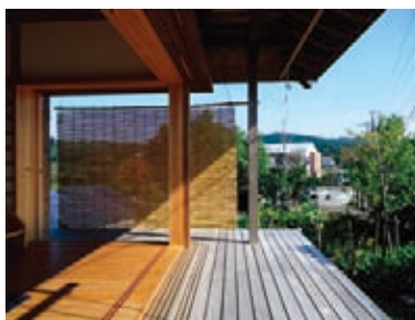
深い軒・縁側・すだれ・掃き出し窓（熊本）
