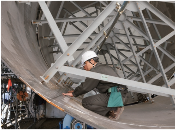
ダム現場から少し離れたところでは放流管の組み立てを行っている。直径4.8m、長さ6mの管を地上で組み立て、ダムに開けた穴の中で継ぎ合わせる。
