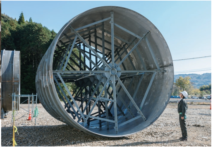
ダム現場から少し離れたところでは放流管の組み立てを行っている。直径4.8m、長さ6mの管を地上で組み立て、ダムに開けた穴の中で継ぎ合わせる。
