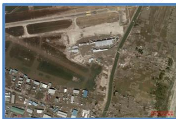
東日本大震災直後の仙台空港付近
