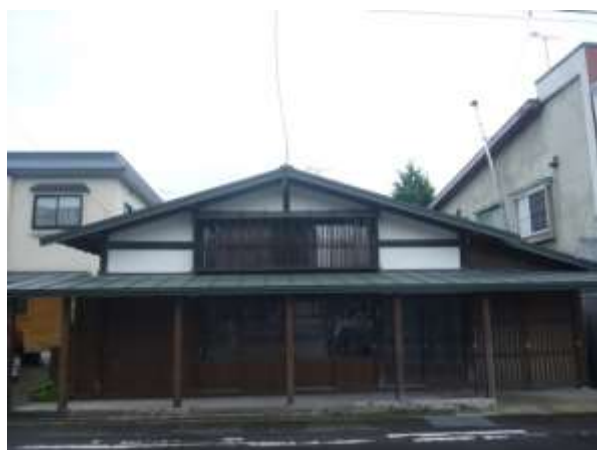
中町伝統的建造物群保存地区保存計画の基準により保全された住宅
