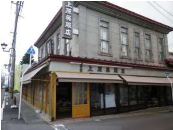
こみせに木のサッシが設置され、外側に庇の出ている店舗併用住宅（店舗営業中はこみせを通り抜けることができる）
