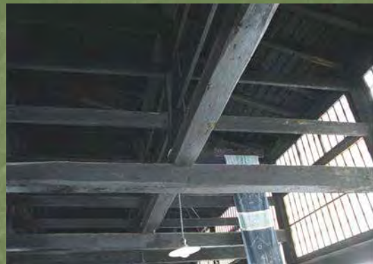
高橋家住宅・小屋組み
