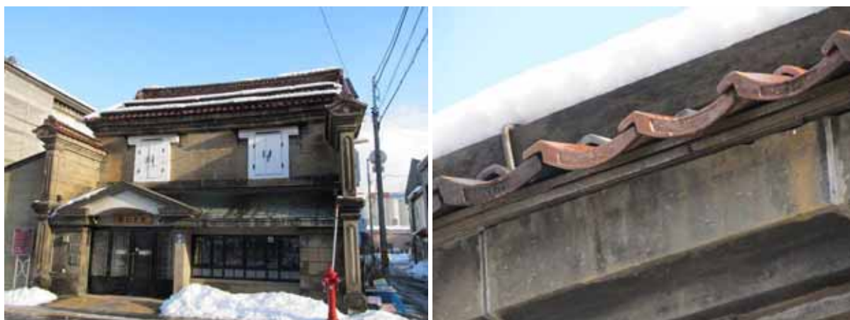
写真 1-11 小樽市にある石州赤瓦 ※瑠璃工房 小樽市堺町 (赤瓦研究委員会撮影) 越前赤瓦の屋根に石州瓦が混在 (写真右の左端は越前瓦、右側 3 枚は石州瓦)
