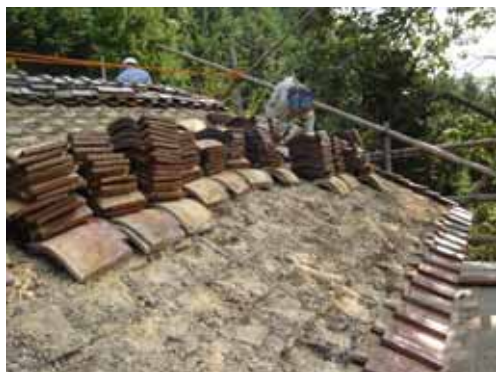
写真 1-52 屋根瓦の撤去工事の状況
