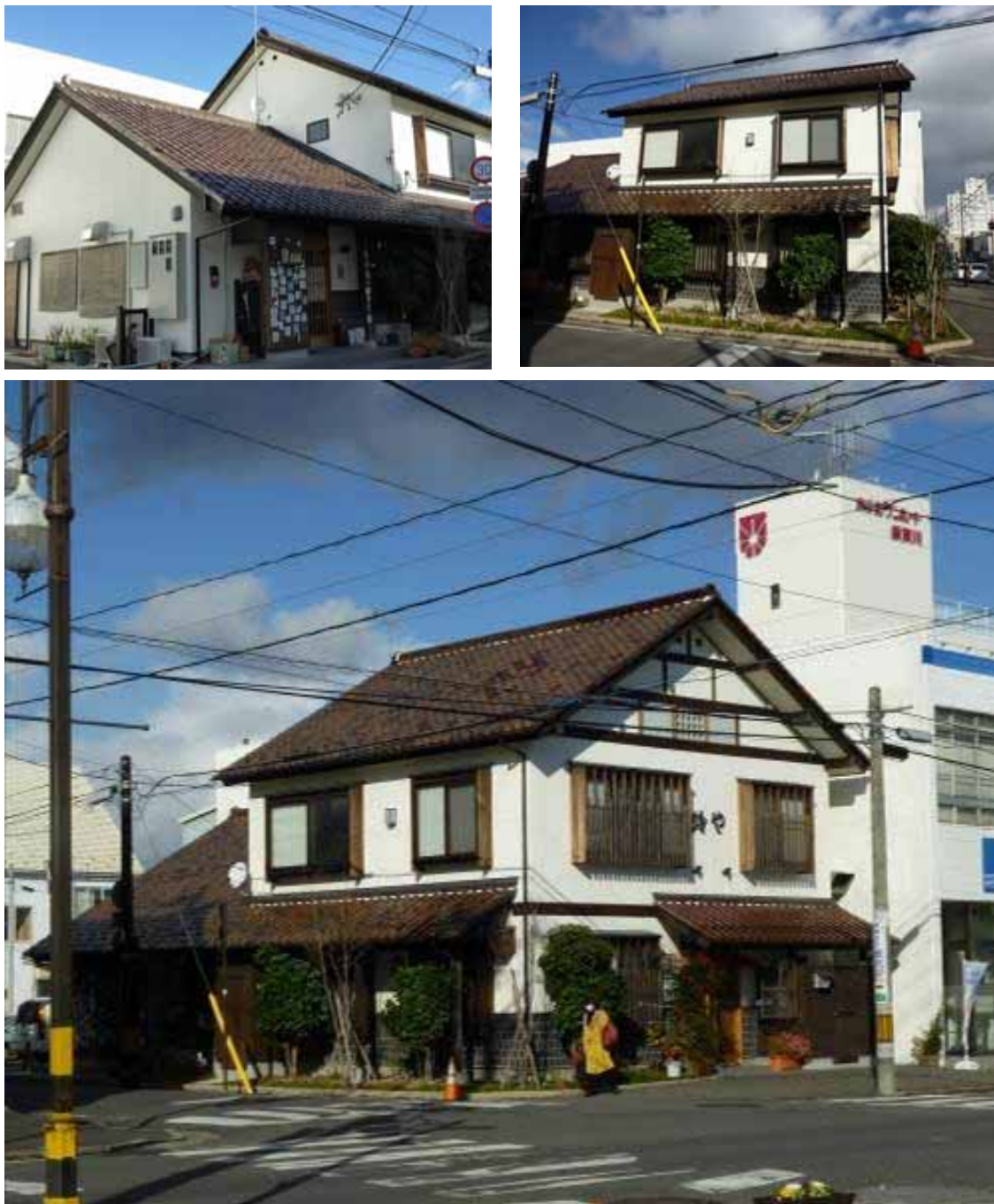
写真 3-2 施工例②（福島県須賀川市）
