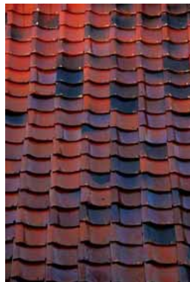
写真3 古瓦で葺かれた屋根
