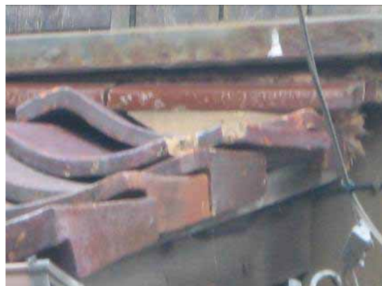
写真 1-24 加賀橋立の赤瓦 ほとんどが光沢の少ない越前系の赤瓦。加賀市橋立（阿部委員提供(2012 撮影)） 北前船船主を多数輩出した集落として知られ、集落内には「石見焼」の陶器が多い。
