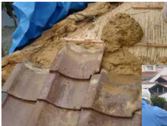
隅棟部分の施工1
