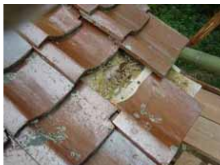
写真 1-51 改修前の郷蔵屋根瓦の状況
