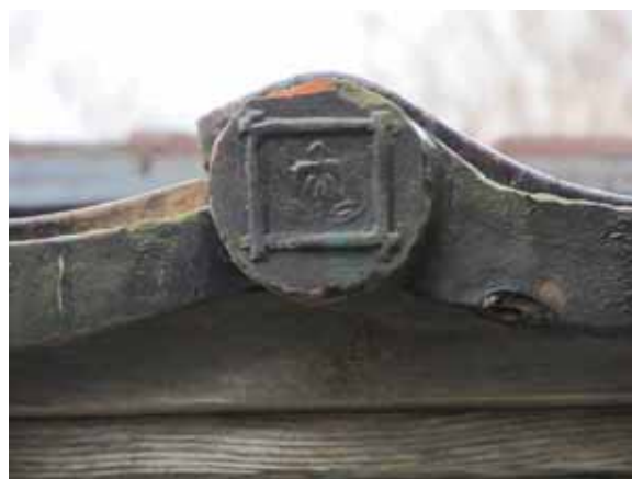
写真 1-16 江差の越前瓦 ※江差法華寺 北海道江差町 (赤瓦研究委員会撮影) 左:越前赤瓦 右上:越前瓦の黒い釉薬瓦
