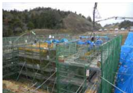
写真 6-18 ボックスカルバート打設の様子
