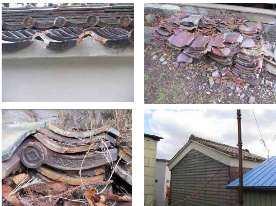
写真 1-18 松前市街地の越前瓦 北海道江差町 (赤瓦研究委員会撮影) 松前の市街地にも赤瓦が点在するが、越前系のものが多く、欠け、割れなどの破損が目立つ。
