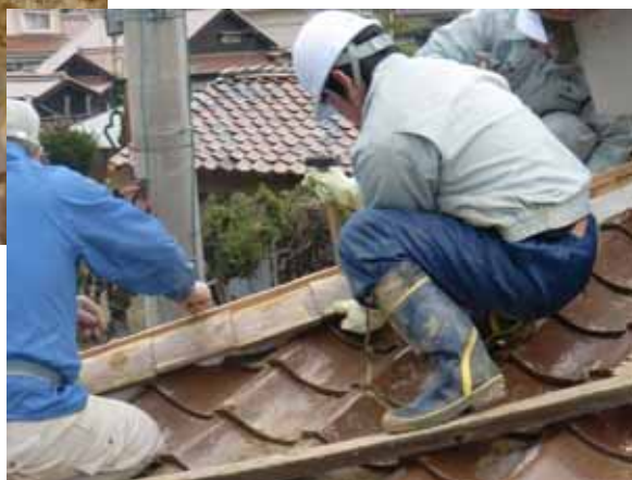
写真 1-78 瓦葺きの状況4
