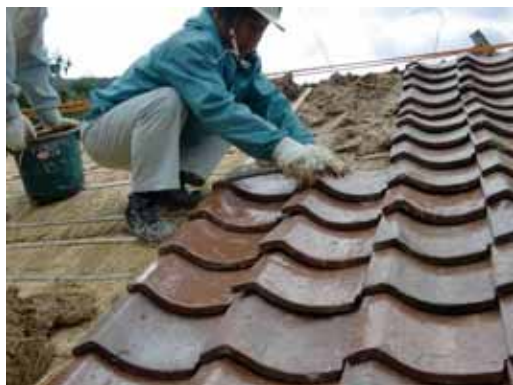
平瓦の施工
