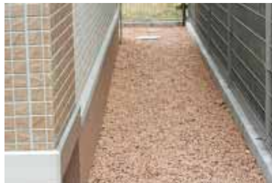
写真 6-12 外溝部の舗装としての施行例
