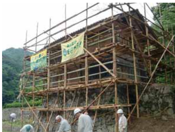
写真 1-50 改修工事中の郷蔵
