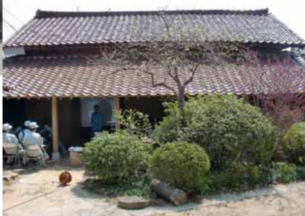
写真 1-67 改修工事をした蔵の下屋部分
