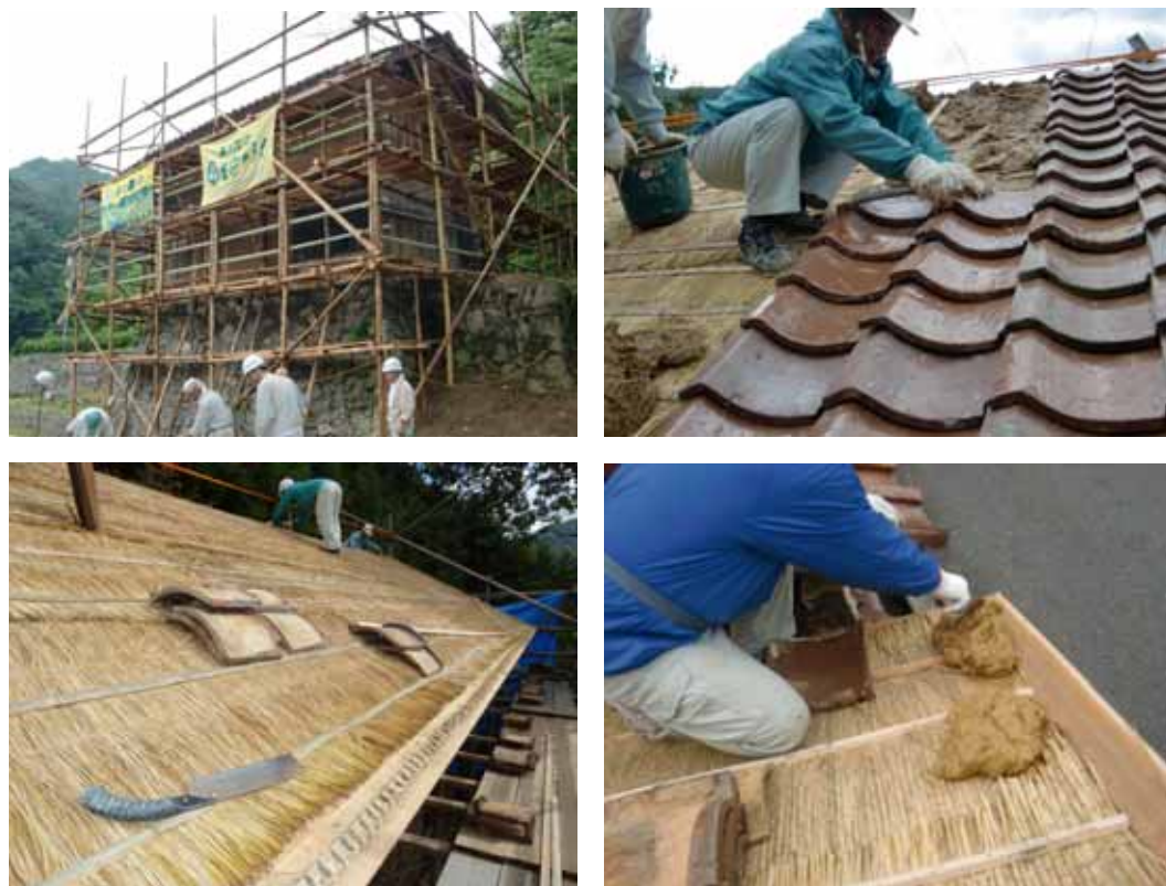
写真 2-11 左官による土葺き作業
