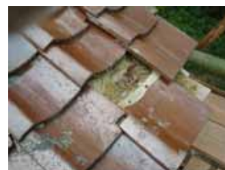
写真 2-3 釘穴がなく ひっかけもない古瓦
