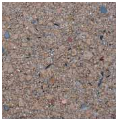
写真 6-8 アスファルト舗装の表面
