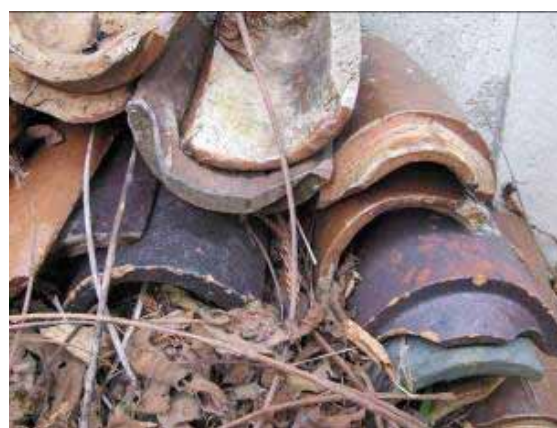
写真 1-17 石州赤瓦と越前赤瓦などの混在 ※松前法華寺 北海道松前町 (赤瓦研究委員会撮影) 左上:本堂の大部分は石州赤瓦 右上:庫裏の右側は飴釉系の光沢のある他産地の瓦 下:庫裏の裏に山積みになっている石州赤瓦と越前赤瓦
