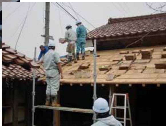
写真 1-75 瓦葺きの状況 1
