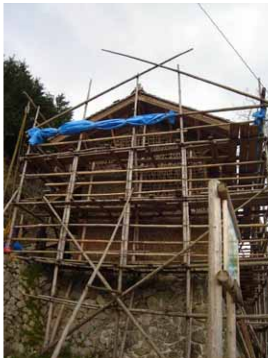
写真 1-63 壁土下地(小舞竹+縄)
