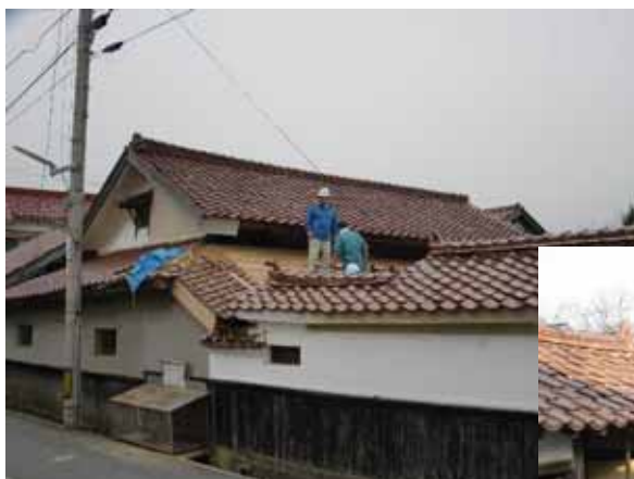
写真 1-79 道路側からの工事状況
