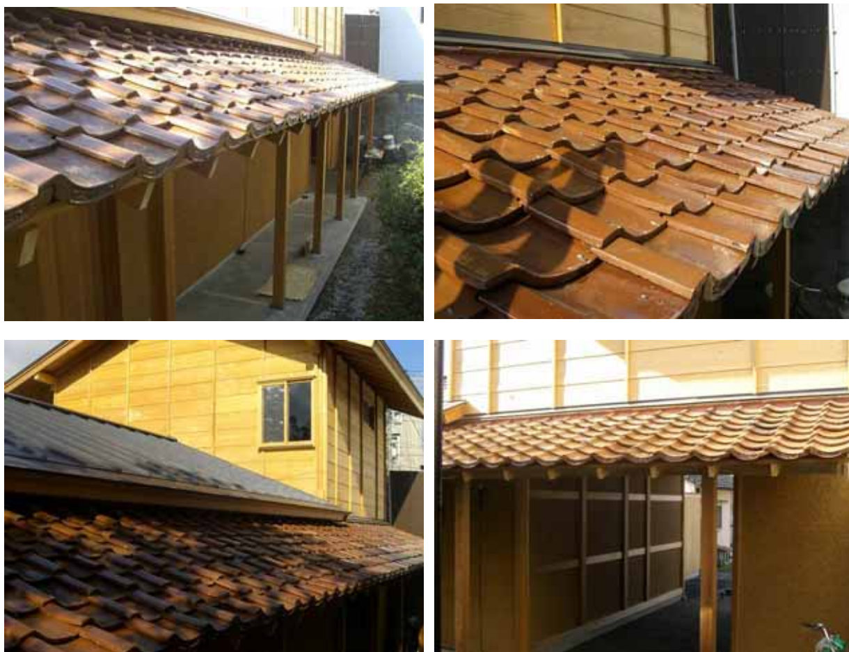
写真 3-1 施工例①（大分県湯布院市）
