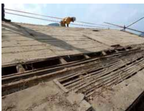
写真 1-54 屋根下地野地の状況
