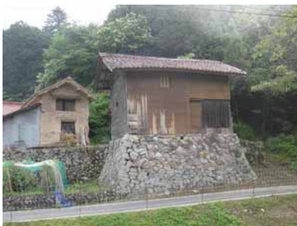
写真 1-49 改修前の郷蔵(1847年～)
