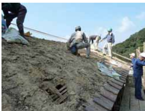
瓦土の改修作業
