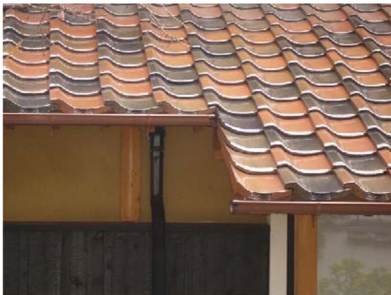
写真3-29 新瓦による古瓦の風合いを持たせた屋根の施工例
