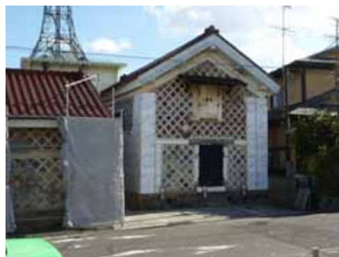
写真3-36 被災した建造物（須賀川市）
