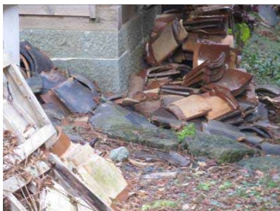
写真 1-17 石州赤瓦と越前赤瓦などの混在 ※松前法華寺 北海道松前町 (赤瓦研究委員会撮影) 左上:本堂の大部分は石州赤瓦 右上:庫裏の右側は飴釉系の光沢のある他産地の瓦 下:庫裏の裏に山積みになっている石州赤瓦と越前赤瓦
