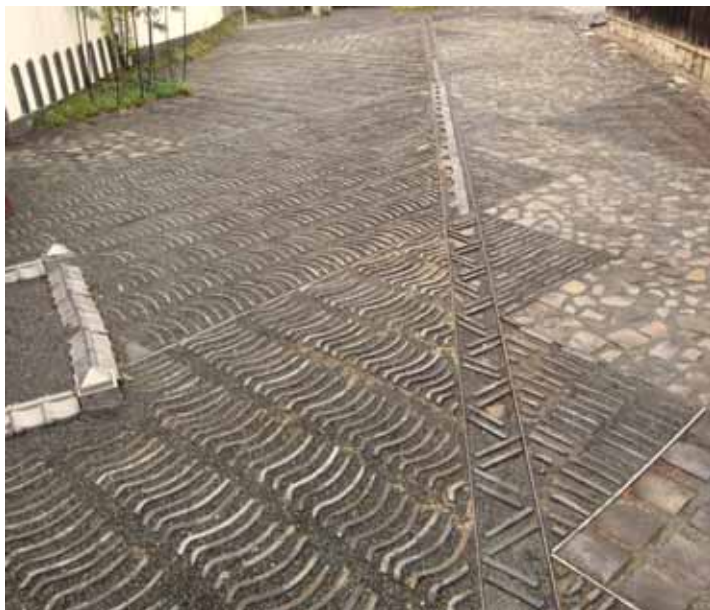
写真 6-7 廃材となった瓦そのものを利用した瓦畳舗装
