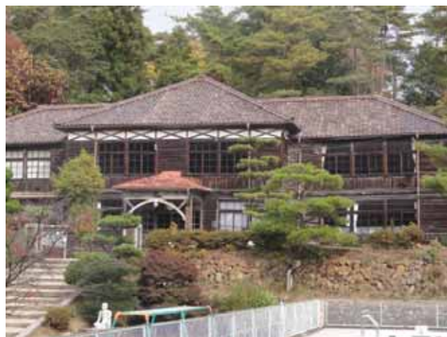
写真 1-29 旧吹屋小学校
