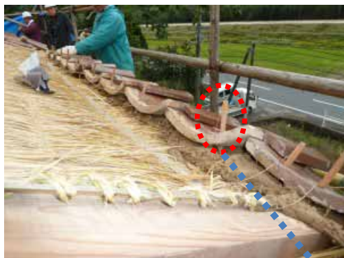
写真 1-59 軒瓦葺き (松釘使用)
