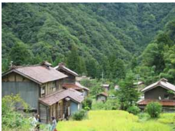
写真 7-6 加賀東谷重要伝統的建造物群保存地区
