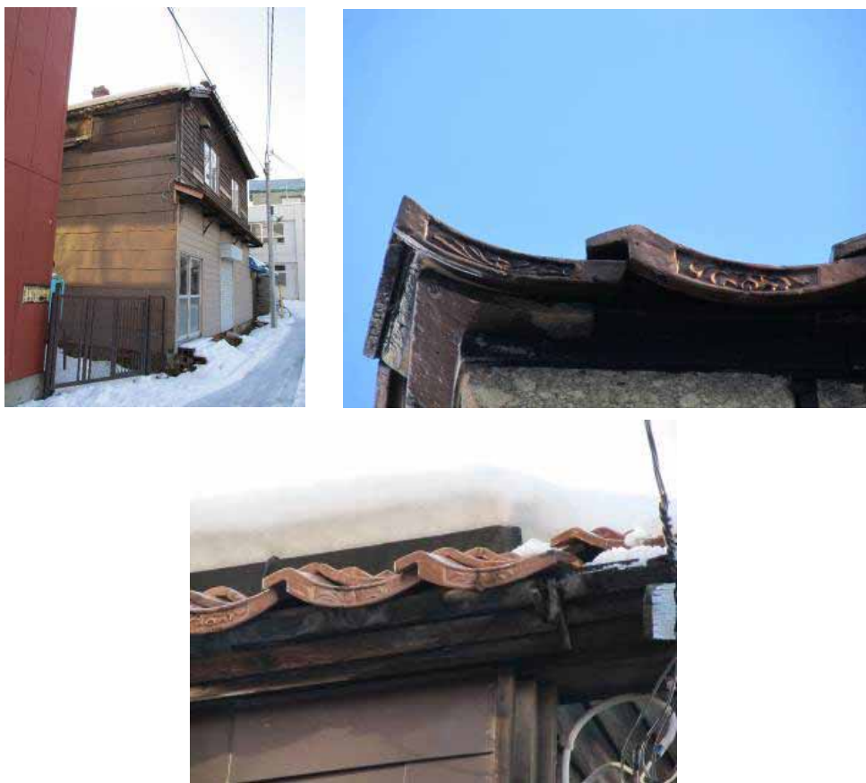
写真 1-10 小樽市にある石州赤瓦 ※モリカワ産業本社 裏の倉庫 小樽市堺町 (赤瓦研究委員会撮影)
