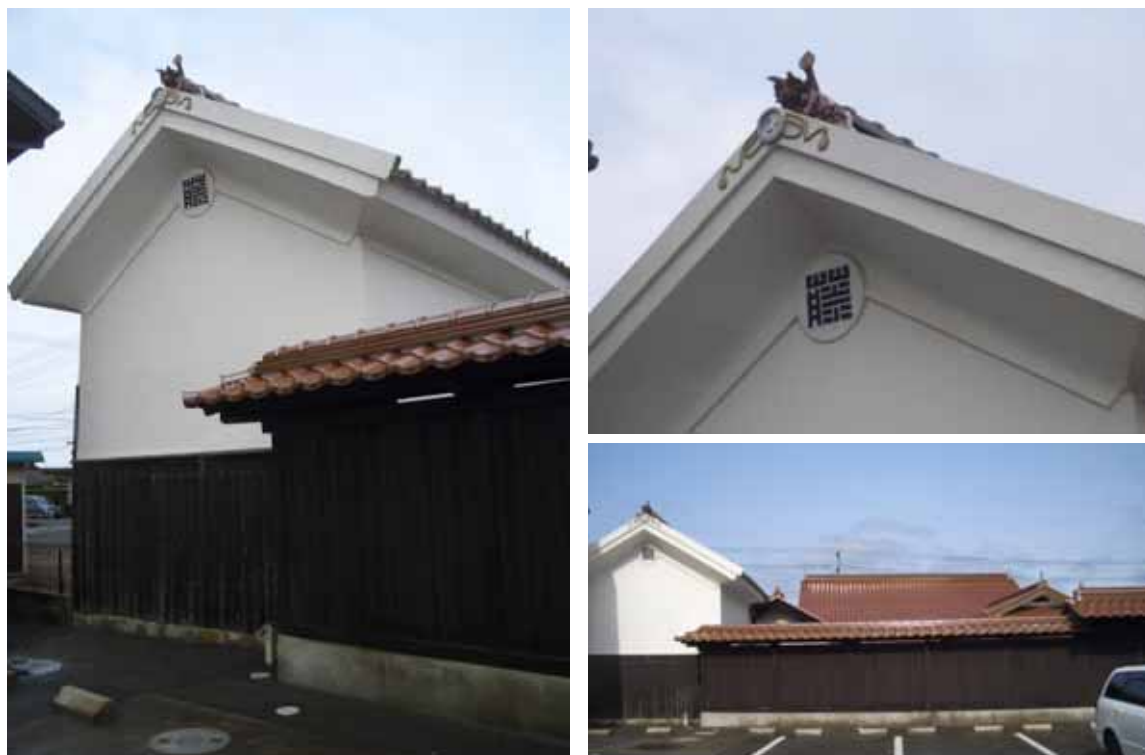
写真3-43 補修された蔵と鰻絵（江津市都野津 藤代酒店）
