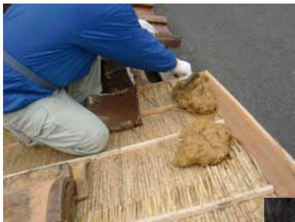
ケラバ部分瓦土
