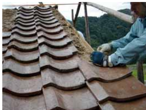
ケラバ瓦の施工
