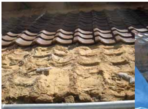
写真 1-68 古瓦の撤去で表れた瓦土
