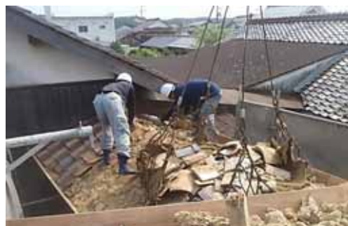
写真 4-3 市内で廃棄されている古瓦
