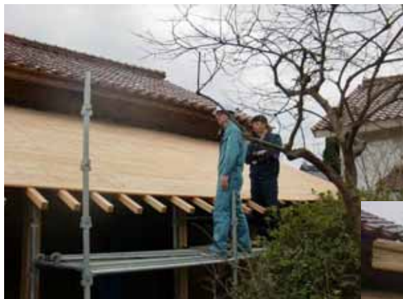
写真 1-73 野地板張り(杉板)
