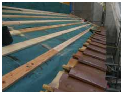
写真 2-6 空葺き(横棧工法)
