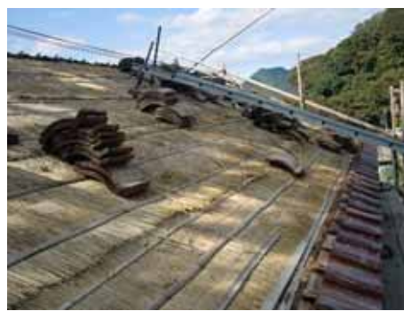
写真 1-56 軒先瓦施工
