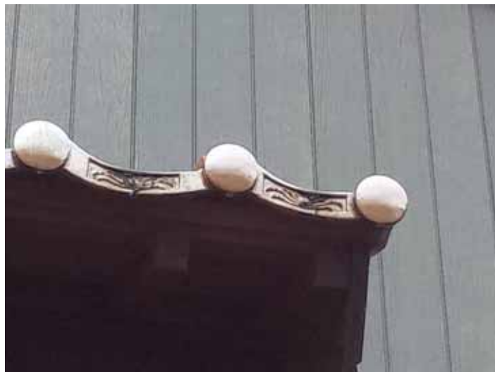
写真 1-8 瓦頭部の唐草文様の中心が 丸印 の新しい石州瓦 (浜田市黒川町)
