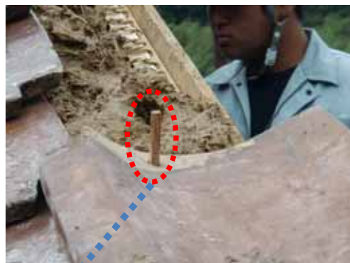
写真 1-60 ケラバ瓦葺き (松釘使用)
