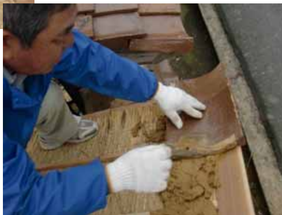
写真 1-76 瓦葺きの状況 2
