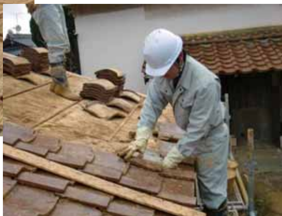
写真 1-77 瓦葺きの状況 3
