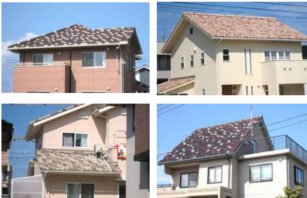
写真3-30 新しい住宅の混ぜ葺きの施工例
