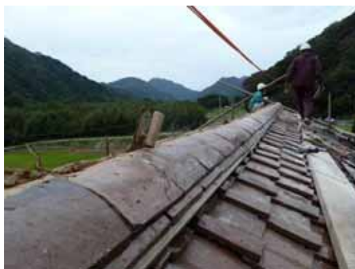
写真 1-62 瓦葺きの状況
