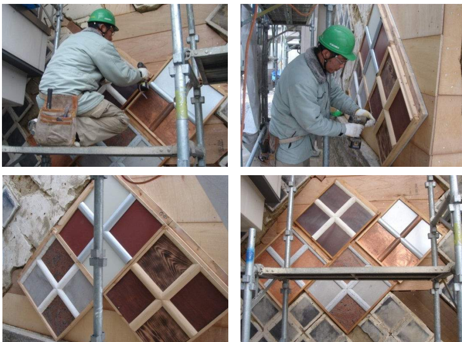
写真4 壁面への施工状況
