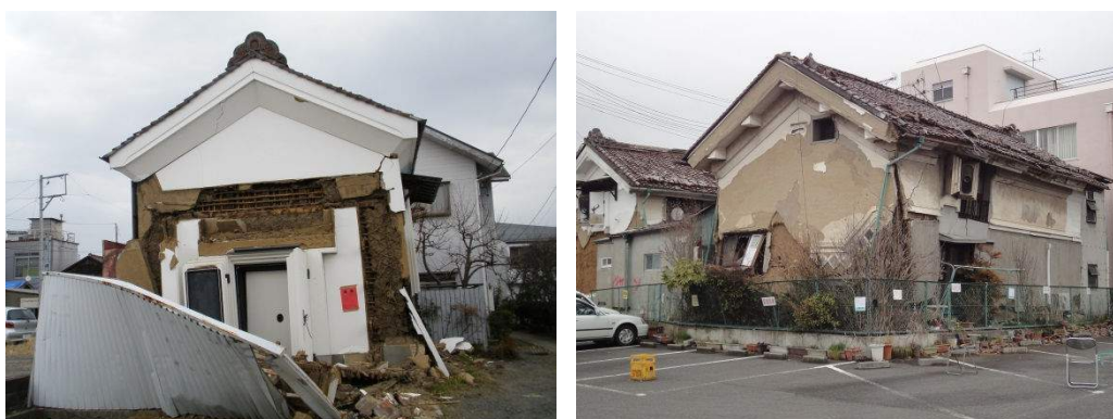
写真1 市内の土蔵被災の様子
