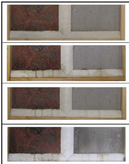
図 4.3.3 なまこ部の汚れ (上から, 0 サイクル,1 サイクル,3 サイクル,40 サイクル)
