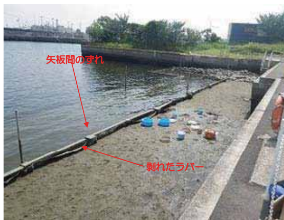
写真 平成 23 年 8 月の矢板の状況
