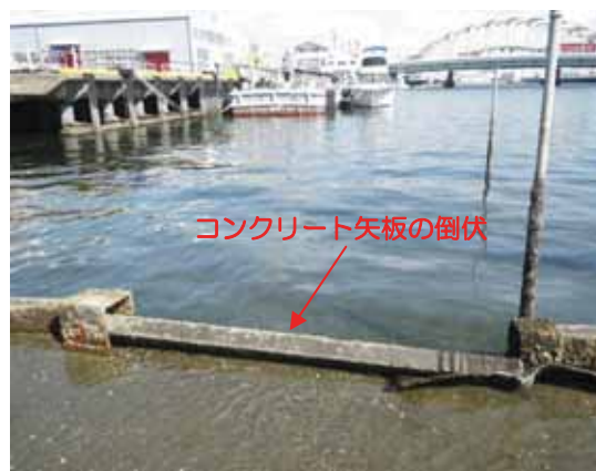
写真 平成 23 年 8 月の矢板の状況
