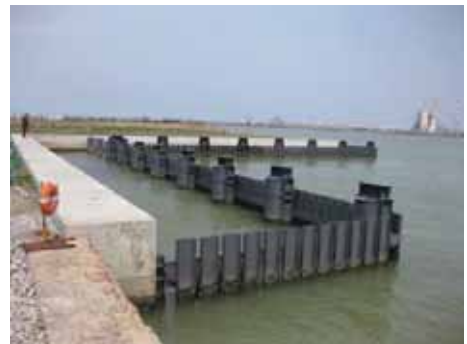
▲ 整備後の様子
