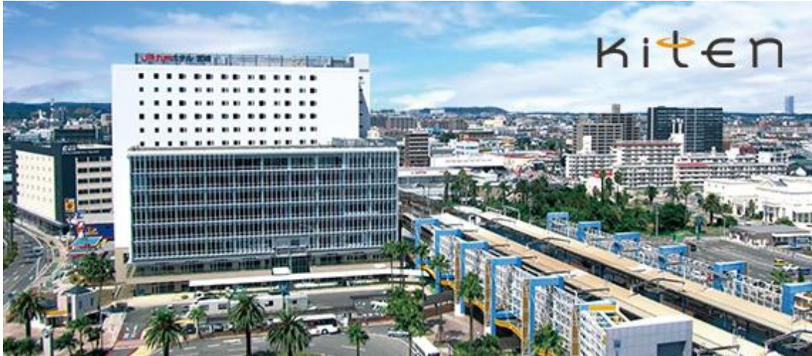
図表 144 宮崎グリーンスフィア壱番館の外観
