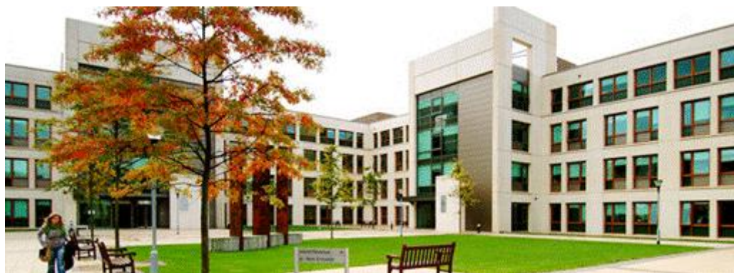
図表 171 DEFRA ケンブリッジ庁舎の外観
