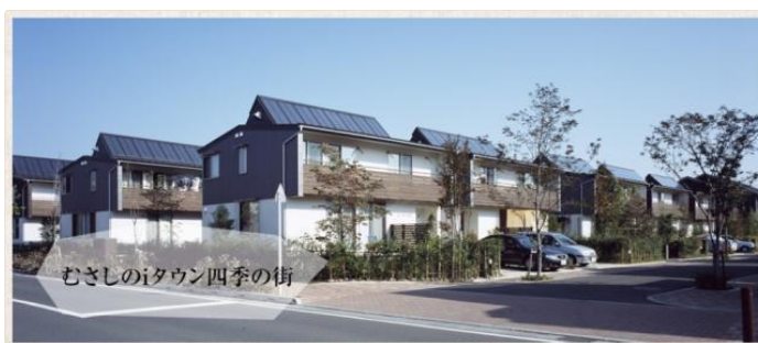
図表 112 整備した施設の外観
