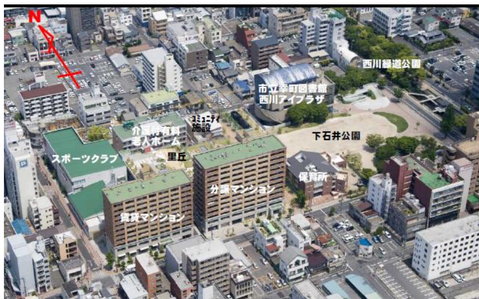
図表 123 完成施設の上空写真
