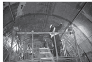
繊維シート貼付
