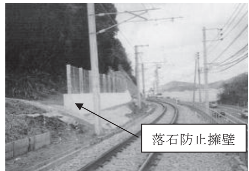
【落石防止擁壁の一例】
