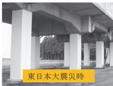
【高架橋の補強】
