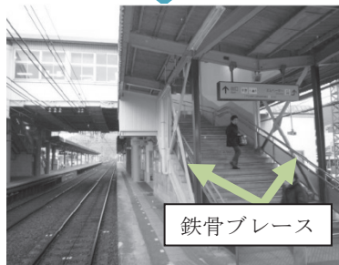
【橋上駅の補強】
