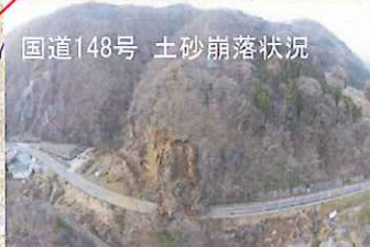
国道148号 土砂崩落状況 国道148号 (通行止め)
