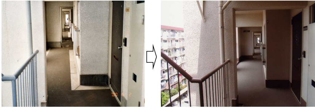
建物の内部廊下床・内壁の仕上げ材料のグレードアップ
