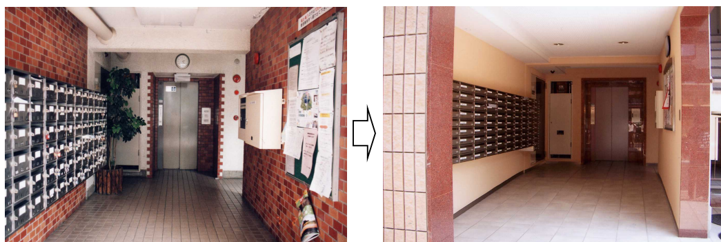
エントランスホールの仕上げ材料のグレードアップ（併せて、集合郵便受け、照明等のグレードアップ）
