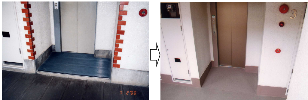
エレベーター出入り口の段差の擦り付け
