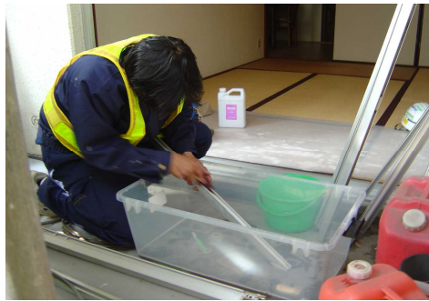
サッシ框の取り外しによる表面の汚れの除去
