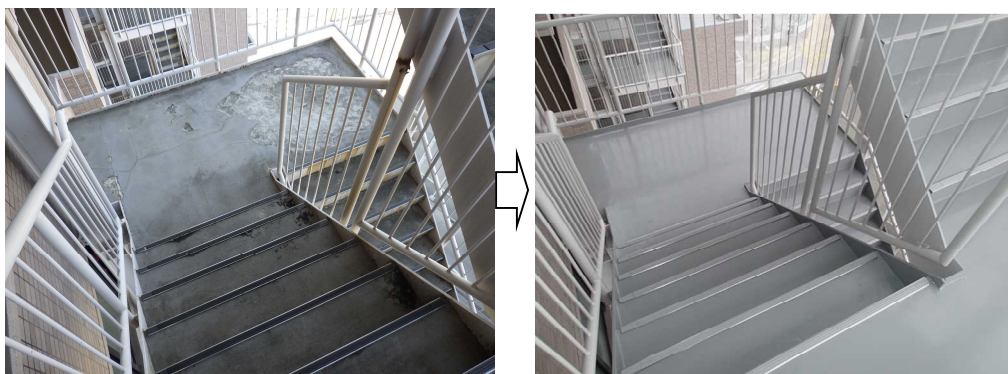
損傷した外階段の改修(防水改修、消音シートの張り付け等)
