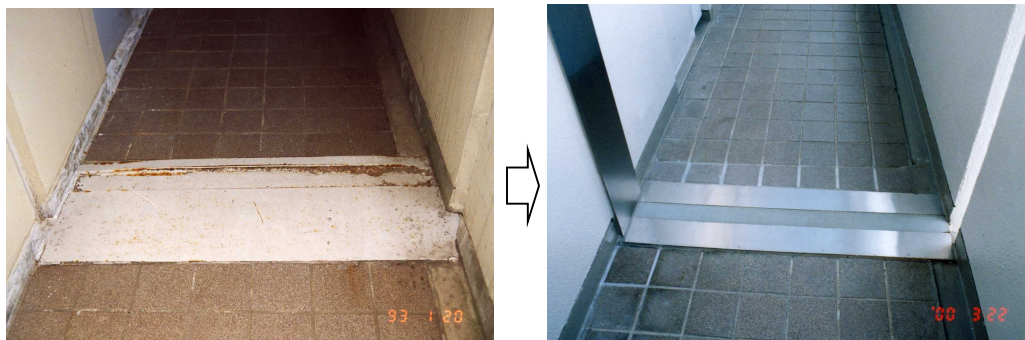
鉄板製の損傷したエキスパンションジョイントをアルミ合金製のものに付け替え
