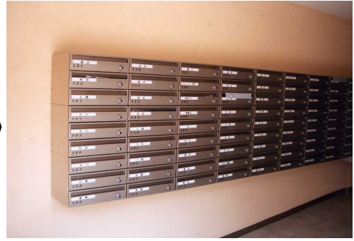
集合郵便受けのグレードアップ(スチール製からステンレス製・全戸ダイヤル式鍵付きタイプへ)
