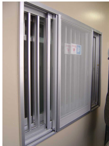
非常時脱出機能付き面格子の設置
