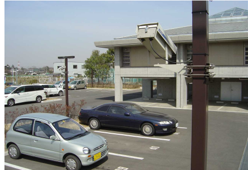
住棟から離れた駐車場への防犯カメラの設置
