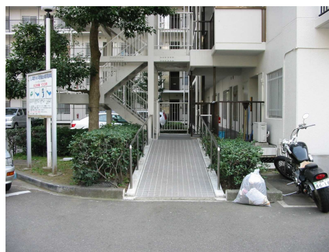
取替え後の屋外鉄骨階段と階段へのスロープ設置
