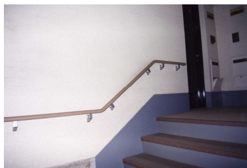
共用階段への手すり設置
