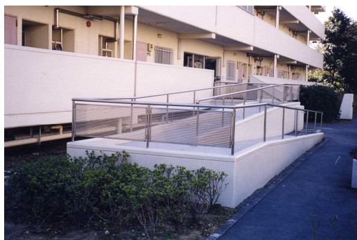
1階共用外廊下へのスロープ設置
