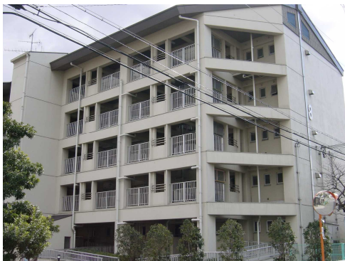
増築部分を北側から見たところ
