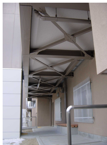
増築された廊下(ブリッジ)を見上げる。増築廊下は鉄骨造。
