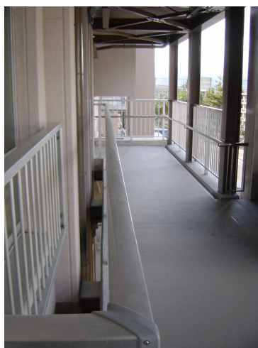
増築された廊下(ブリッジ)。右手中央にEV出入り口がある
