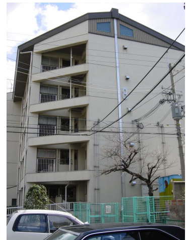
妻側から見たところ (左半分が増築部分)
