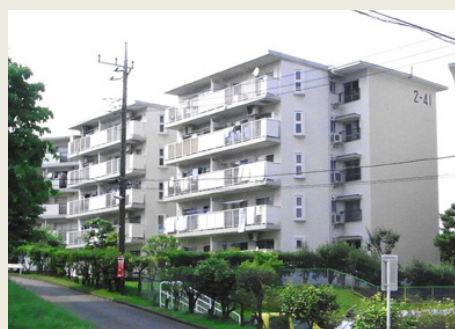
増築後の建物
