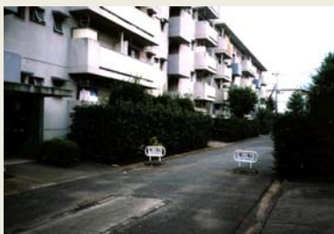
団地内通路改修前
