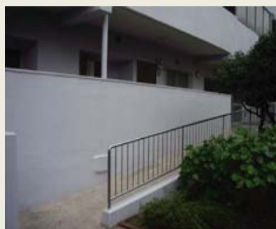
スロープ設置によりバリアフリー化
