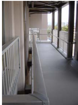
増築された廊下（ブリッジ）。 右手中央にEV出入口がある
