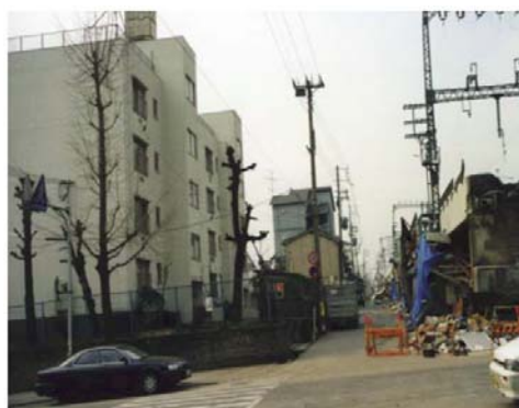
RC造・壁式構造の住棟（4階建て）
