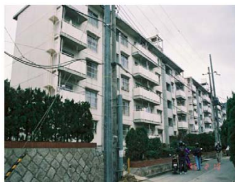
PC板構造の住棟（5階建て）
