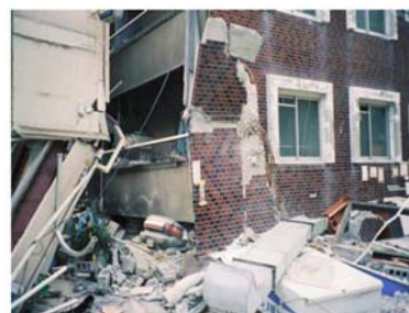
RC造ラーメン構造の駐車場 ピロティ型マンション
