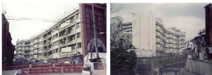
RC造・ラーメン構造の細長い住棟（5階建て）
