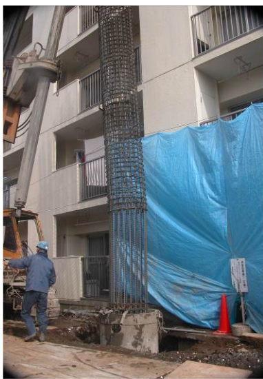
写真 1.3 杭施工状況
