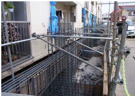
写真 1.4 外付けフレーム下部配筋状況
