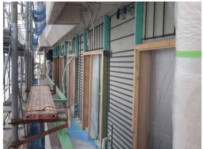
鉄筋取付状況
