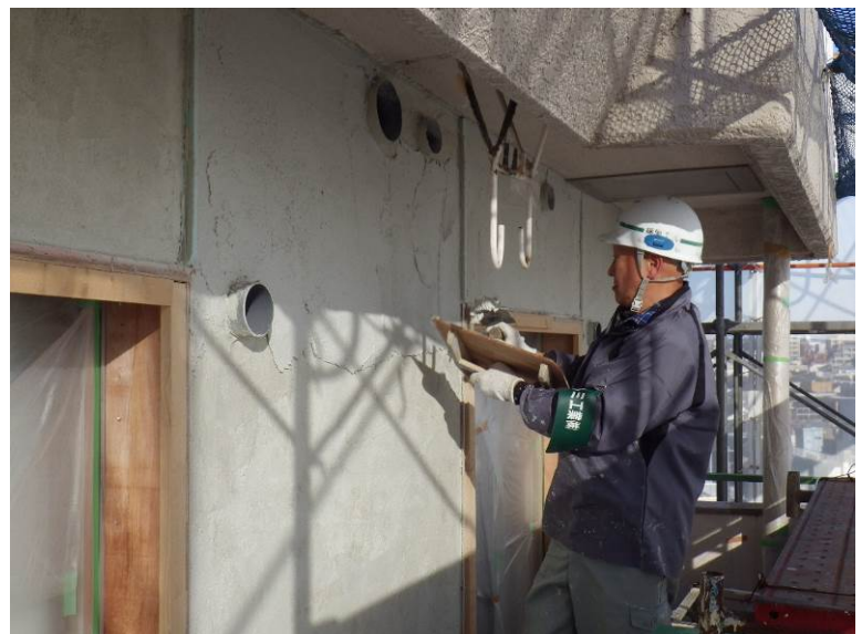
ポリマーセメントモルタルの塗り込め
