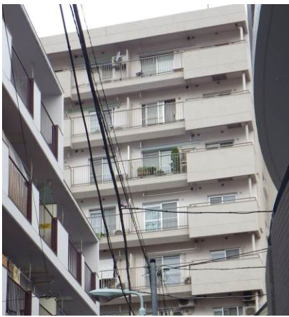
写真 2.1 建物外観写真（補強後） 上より3層と4層目を補強
