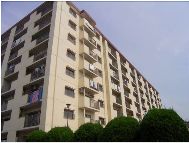
写真 1.1 建物外観写真（改修前）
