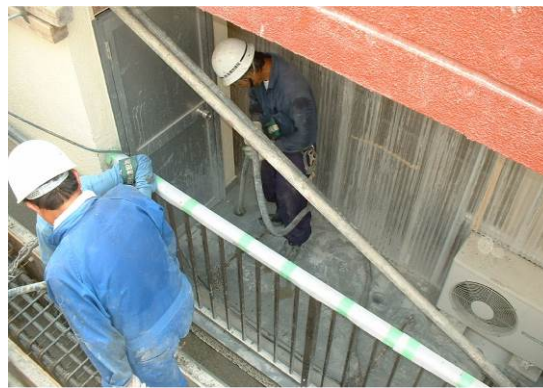
写真 1.6 増設スラブコンクリート打設
