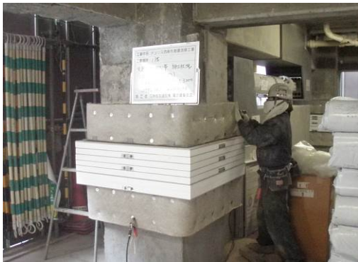
免震装置への耐火被覆の設置
