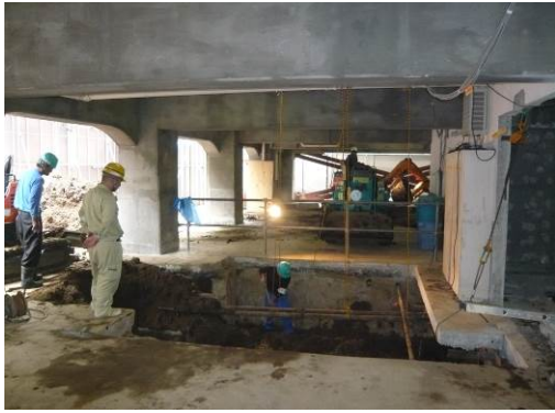
基礎梁補強のための掘削状況
