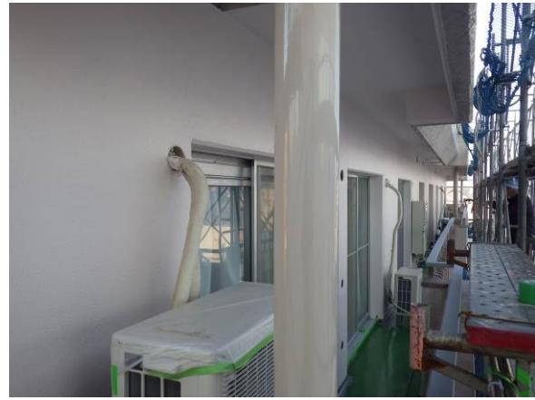
写真 2.5 補強部写真（補強後）ベランダ
