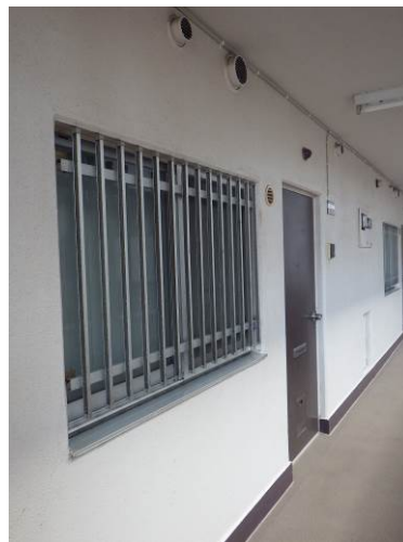
写真 2.2 補強部写真 （補強前）内廊下
