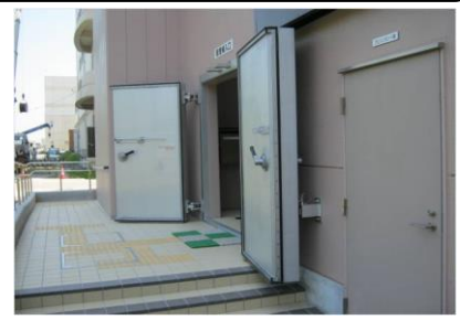
防水扉の設置 (仙台市南蒲生浄化センター)
