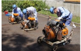
下水道BCPに基づく訓練 (H25.5月,11月横浜市)
