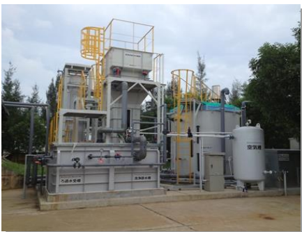
実証試験実施状況 (ベトナム・ダナン市)
