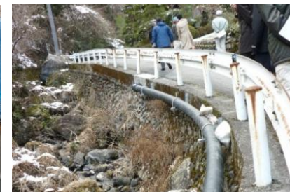
クイック配管(露出配管)
