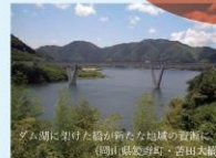
ダム周りに佇む船が新たな地域の景観に (岡山県児島町・空田大橋)
