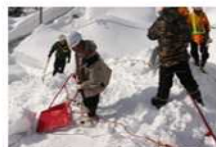
転落防止対策(命綱、アンカー)
