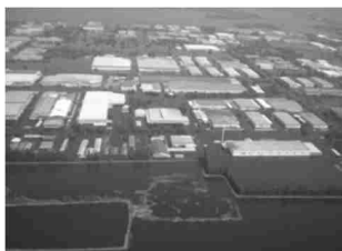
タイで発生した洪水によるロジャナ工業団地の浸水状況(2011年)
