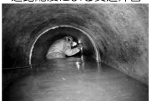
苛酷な環境での管渠の 点検・維持管理
