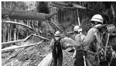
地上からの被災状況調査 【H26.8 月豪雨】 (兵庫県丹波市)
