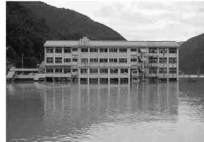
H26.8 避難所 2 階の浸水 (徳島県阿南市)
