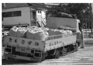
道路陥没による交通障害
