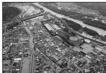
由良川沿川の被災状況（京都府福知山市）
