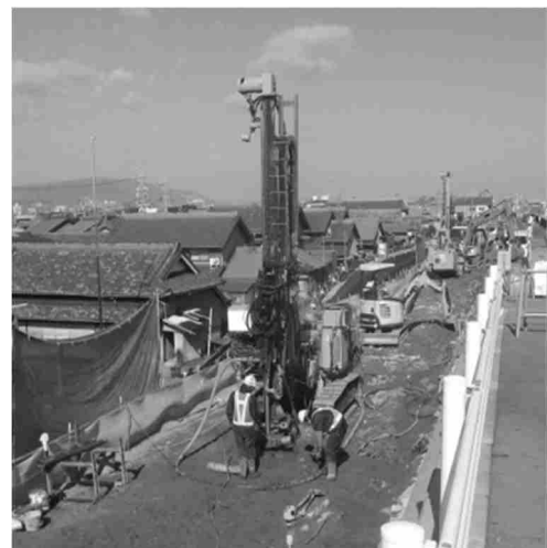
締りめ工法による地震・津波対策（三重県桑名市）
