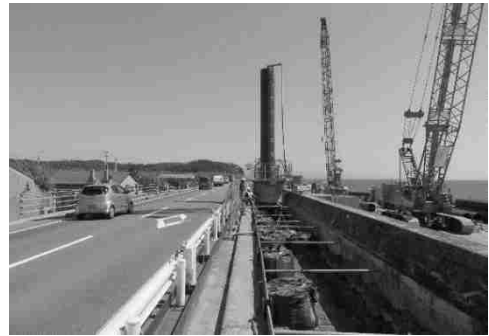
海岸堤防の耐震・液状化対策（高知県高知市）
