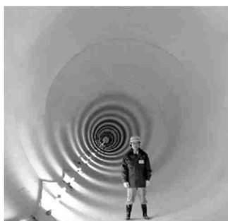
地下に整備された貯留施設 (名古屋市)
