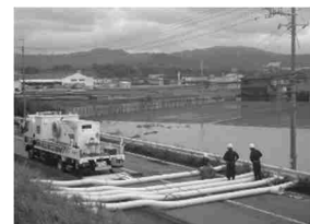
排水ポンプ車による緊急排水 【H26.8 月豪雨（台風第 12・11 号）】 (和歌山県紀の川市)
