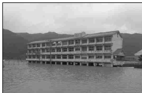
徳島県 阿南市 那賀川水系の浸水状況（台風11号）
