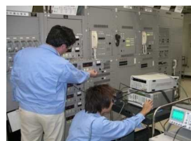
(航空保安施設点検実施状況)
