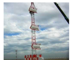
(老朽化した計器着陸装置の更新)
